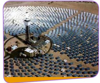
منشأة لتوليد الطاقة الحرارية الشمسية ويجري حالياً إنشاء من قبل شركة سوليل وهي مصممة لتكون قادرة على توليد طاقة قدرها 553MW. وعند الانتهاء من العمل سوف تصبح أكبر منشأة في العالم لجمع
